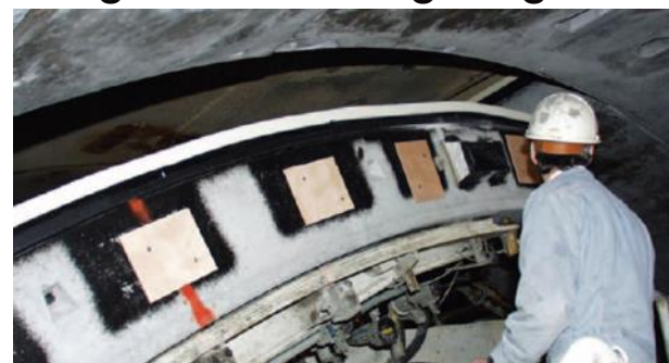
segment met triplex-plaatjes in de ringvoeg
