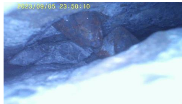
endoscoop-beeld met gebroken wapeningsstaaf
